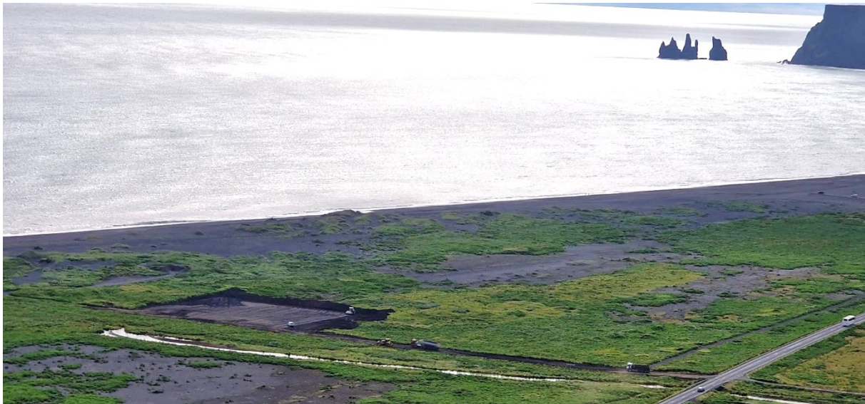
MYND 3.5 Horft yfir vinnslusvæði Lavaconcept ofan af Fagradalshamri. Myndin er tekin á framkvæmdatíma þegar unnið var að jarðvinnu. Svæðið er rétt við Þjóðveg 1 í lúpinubreiðu austan við Vík, Reynisdrangar sjást í fjarska.
